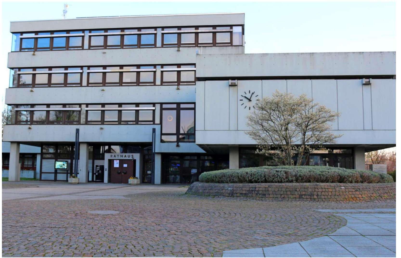
Bad Friedrichshall will klimaneutral werden. Voraussetzung ist unter anderem ein Wärmekonzept, das auch städtische Gebäude wie das Rathaus einbezieht. Foto: Ute Plückthun
